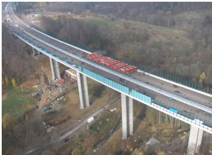
Obr. 2. Zatěžovací zkouška mostu přes Rybný potok (foto J. Vitek).
