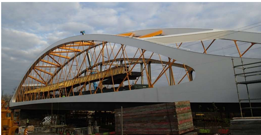
Obr. 1. Zatěžovací zkoušku mostu připravili pracovníci ČVUT v Praze (foto P. Ryjáček).
