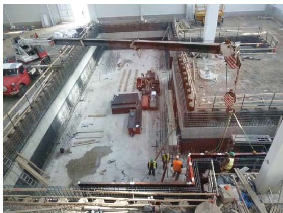
Obr. 2. Betonová vana připravená pro výstavbu dvojice rámových základů Fagor; instalovaná dvojice lisů Fagor (foto D. Makovička).
