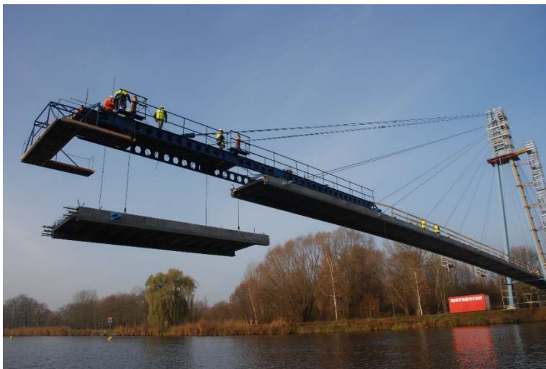
Obr. 1. Montáž segmentu lávky v Čelákovících (foto J. Vítek).
