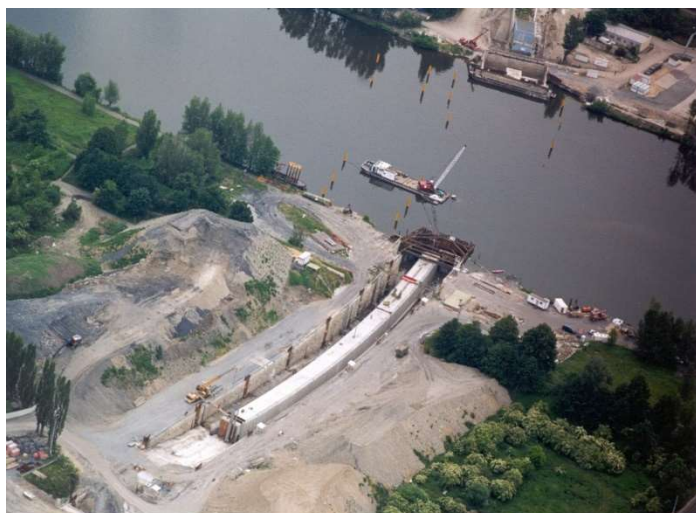
Obr. 1. Tunelová trouba v suchém doku před jeho zaplavením (foto J. Husák).
