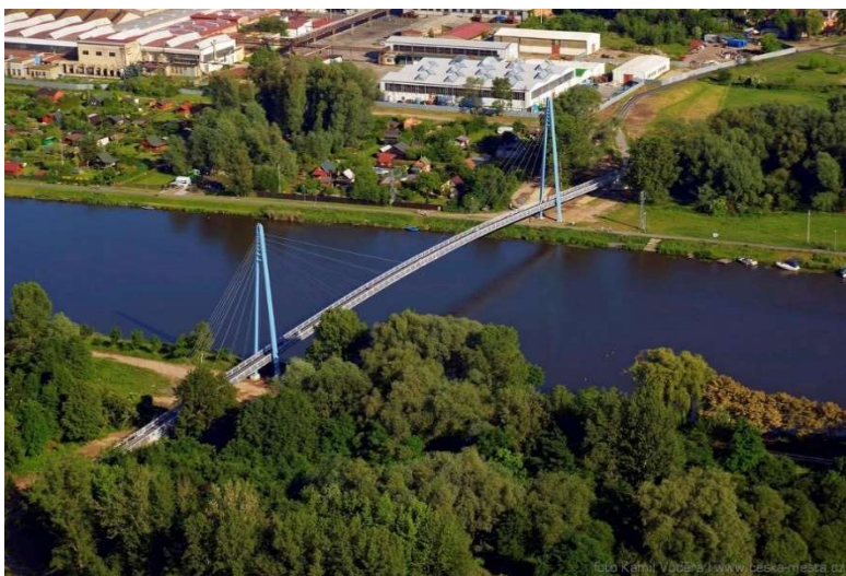
Obr. 2. Hotová lávka přes Labe v Čelákovících (foto Pontex).
