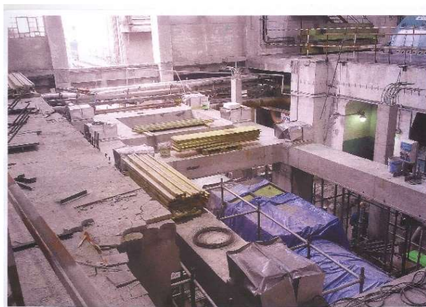
Obr. 2. Stádium výstavby do úrovně pružných vložek, viz označení na obr. 1 (foto D. Makovička).
