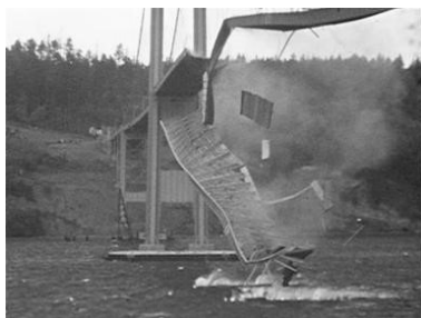
Obr. 1. Havárie zavěšeného mostu v Tacomě (1941) vlivem ztráty stability typu torzní flutter; pravý obrázek demonstruje schéma stabilních (šedivé) a nestabilních oblastí přímého štíhlého prutu při kombinacích flutteru, divergence a dalších kritických stavů.
