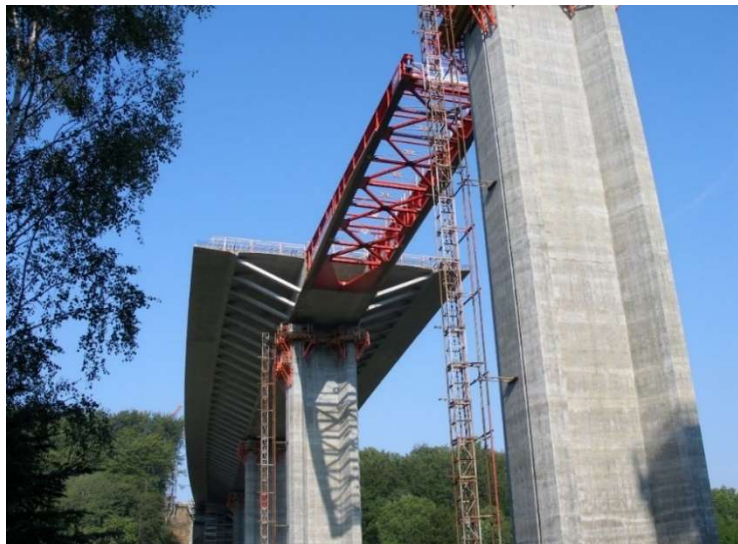
Obr. 1. Výsuv mostu přes Rybný potok na D8 (foto J. Vitek).
