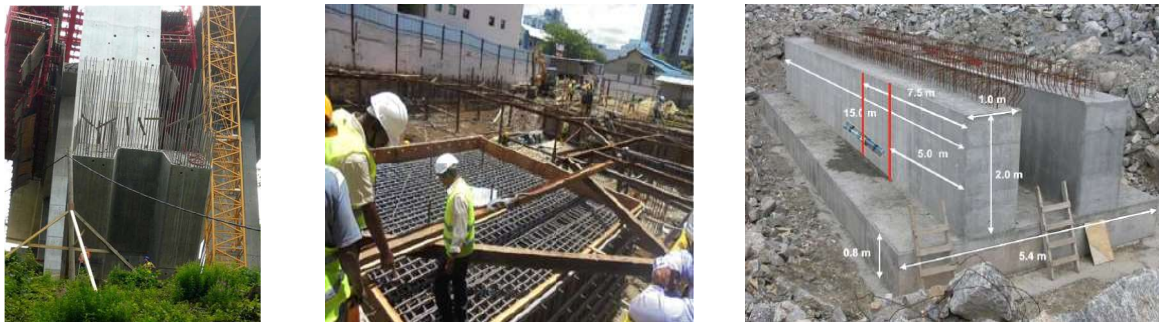
Obr. 2. Oblouk mostu přes Opárenské údolí D8 s vodním chlazením; hlavice pilot na Srí Lance; test ostění pro tunel Björvika v Oslu.
