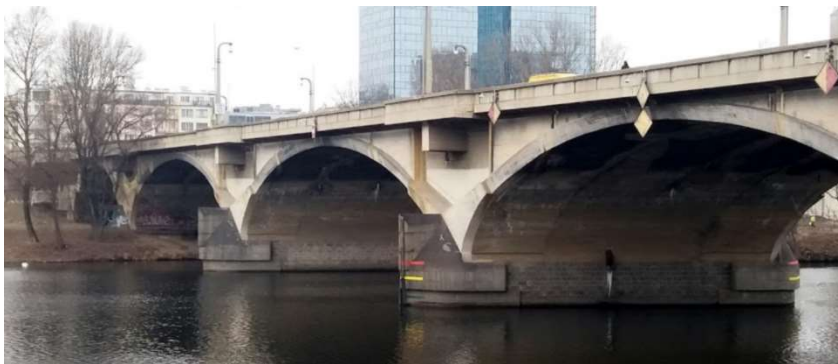
Obr. 1. Testování spolehlivosti Libeňského mostu v Praze.
