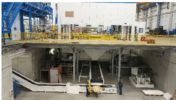
Obr. 2. Betonová vana připravená pro výstavbu dvojice rámových základů Schuler; instalovaný lis Schuler (foto D. Makovička).
