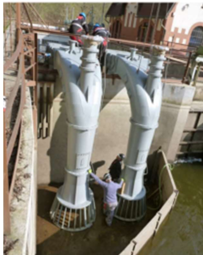
Obr. 3. Stavba malé vodní elektrárny s vírovými turbínami.
