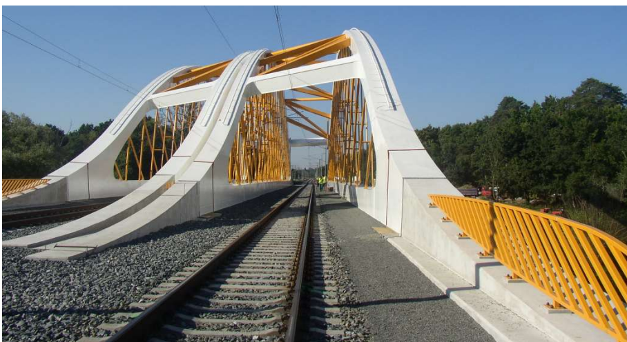
Obr. 2. Pohled na konstrukci mostu (foto P. Ryjáček).
