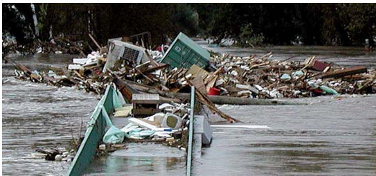
OBRÁZEK 121: Bariéra vytvořená na pěší lávce v Troji v roce 2002 (Foto T. Drdáký)
