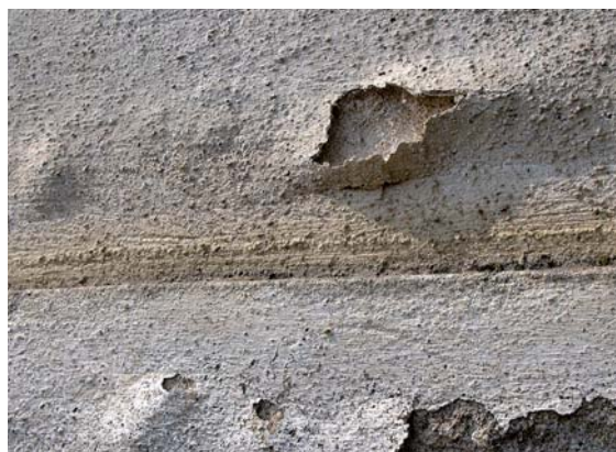
OBRÁZEK 61: Uzavřené a otevřené puchýře v povrchových vrstvách lokálně oddělených od podkladu (jádrové omítky) (Foto M. Drdácký)
