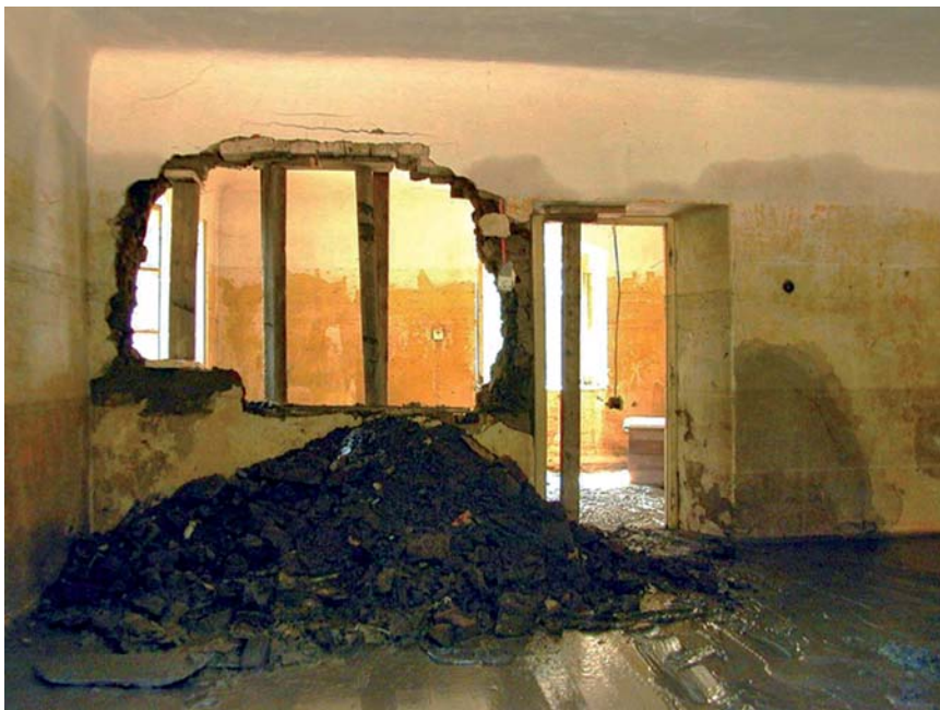
OBRÁZEK 118: Vodním proudem probouraná hliněná zeď – Veltrusy 2002 (Foto M. Dropka)
