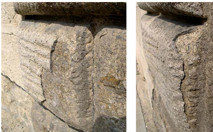
OBRÁZEK 65: Oddělení a odpadnutí opravné vrstvy umělého kamene (Foto M. Drdácý)
