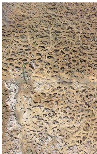
OBRÁZEK 68: Ztráta materiálu seškrábáním stěny, o kterou jsou opírána kola (vlevo), krátery způsobené projektily ze vzduchovky (vpravo) (Foto M. Drdácý)
