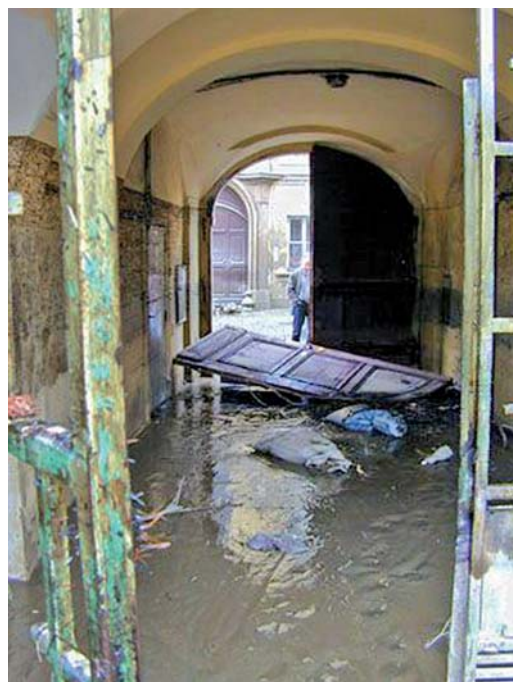
OBRÁZEK 117: Typické vysazení dveřních křídel – ba- rokni dům Praha 2002 (Zdroj http://www.ikaros.cz )
