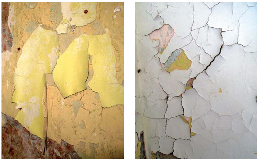
OBRÁZEK 66: Příklad odlupování tenkých vrstev (Foto M. Drdácý)
