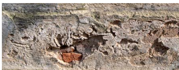
OBRÁZEK 70: Selektivní degradace a eroze (Foto M. Drdácý)
