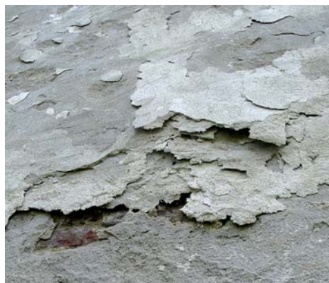
OBRÁZEK 63: Kombinované poškození lístkovatěním souvrství nátěrů (maleb) a štukových vrstev se ztrátou materiálu (vlevo) a lístkovatění vyvolané mrazem (vpravo) (Foto M. Drdácký)
