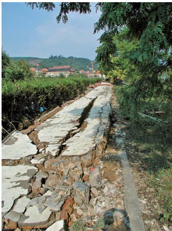
OBRÁZEK 114: Svalená zeď zahrady Trojského zámku povodní v roce 2002 (Foto M. Drdáký)
