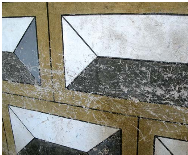
OBRÁZEK 68: Ztráta materiálu seškrábáním stěny, o kterou jsou opírána kola (vlevo), krátery způsobené projektily ze vzduchovky (vpravo) (Foto M. Drdácý)
