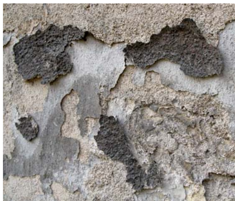
OBRÁZEK 63: Kombinované poškození lístkovatěním souvrství nátěrů (maleb) a štukových vrstev se ztrátou materiálu (vlevo) a lístkovatění vyvolané mrazem (vpravo) (Foto M. Drdácký)
