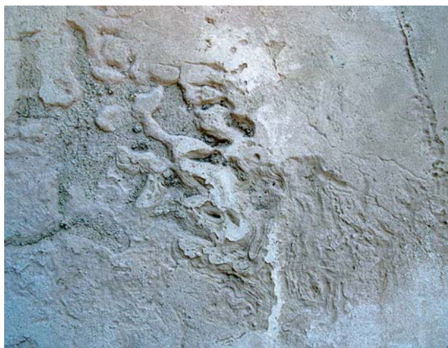
OBRÁZEK 69: Selektivní eroze (vlevo), alveolizace (vpravo) (Foto M. Drdácý)
