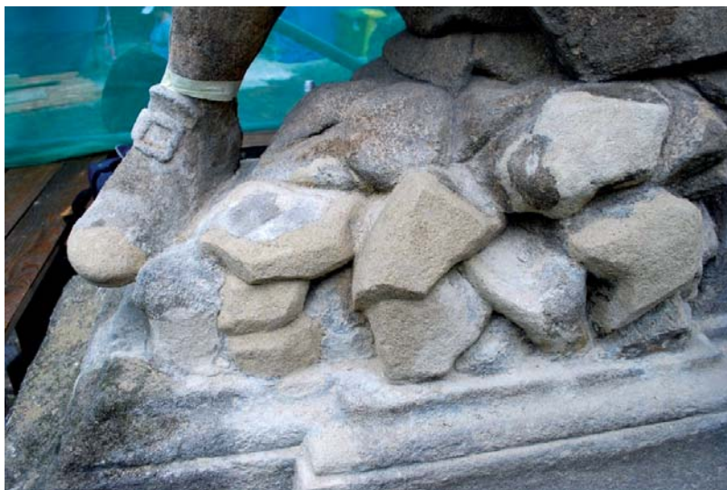
OBRÁZEK 232: Rekonstrukce v umělém kameni, kutnohorský vápenec. Horní kašna, Kutná Hora. Stav v průběhu restaurování v roce 2015. (Foto: V. Douša. Archiv FR UPCE, Litomyšl)
