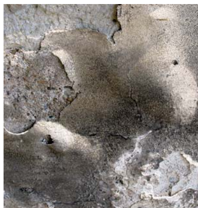
OBRÁZEK 61: Uzavřené a otevřené puchýře v povrchových vrstvách lokálně oddělených od podkladu (jádrové omítky) (Foto M. Drdácký)
