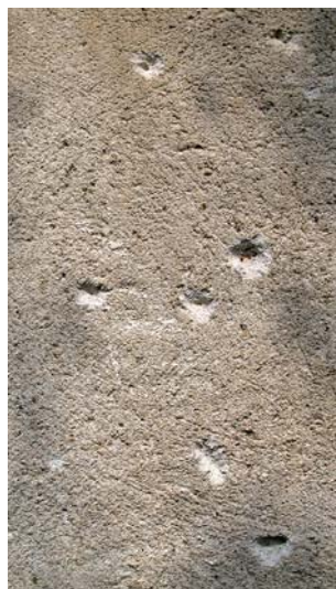
OBRÁZEK 68: Ztráta materiálu seškrábáním stěny, o kterou jsou opírána kola (vlevo), krátery způsobené projektily ze vzduchovky (vpravo) (Foto M. Drdácý)
