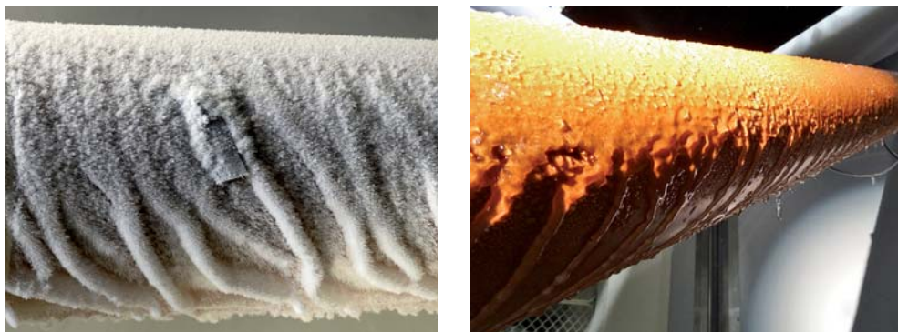
OBRÁZEK 211: Příklad námrazy na úseku mostního lana vytvořené v klimatické části klimatického větrného tunelu CET. Problematika kmitání lan s námrazou nebo vlivem kombinace větru a deště je velmi významná s ohledem na celkovou bezpečnost a spolehlivost konstrukcí s lanovými prvky
