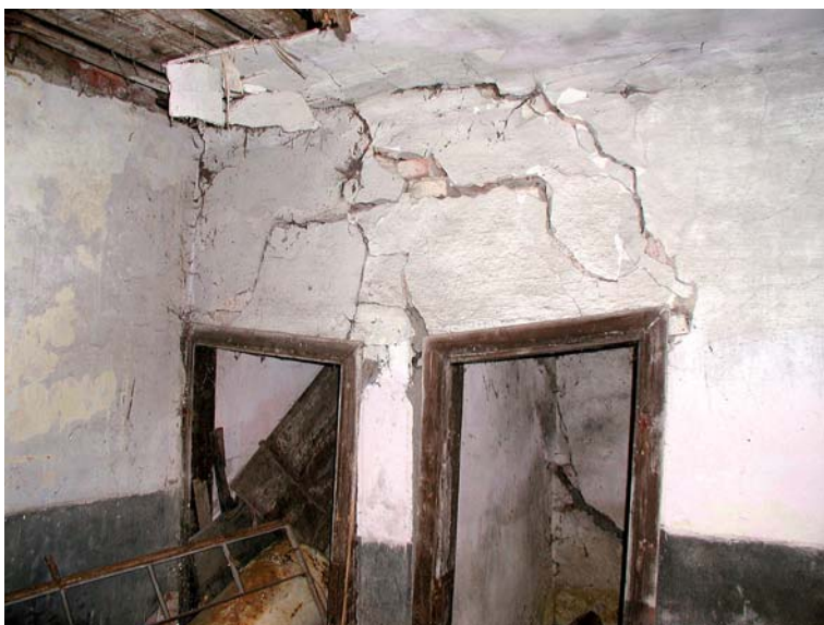
OBRÁZEK 122: Prosednutí násypu pod založením příček ve mlýně v Soběslavi (Foto M. Drdáký)
