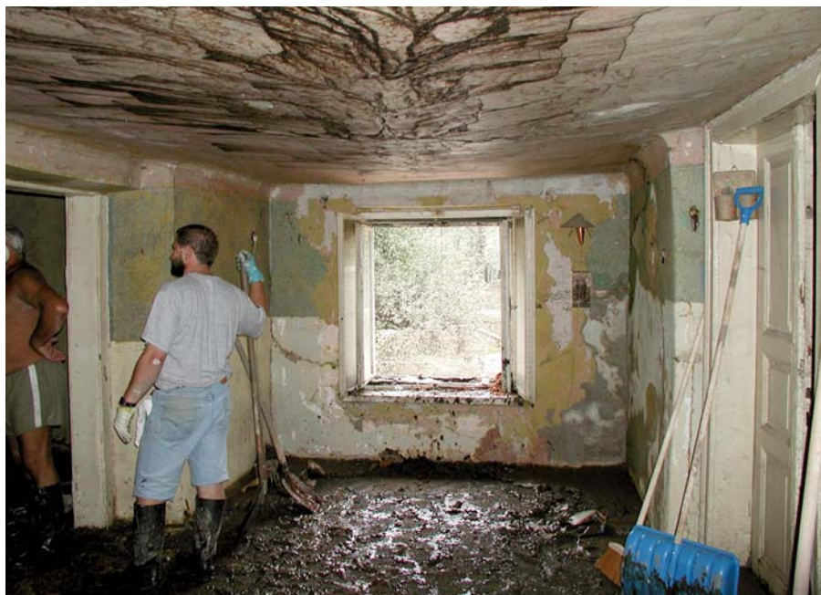
OBRÁZEK 127: Příklad znečištění domu, který byl celý pod hladinou vody (Foto M. Drdácý)
